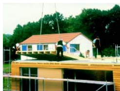
regendichte Montage innerhalb eines Tages
